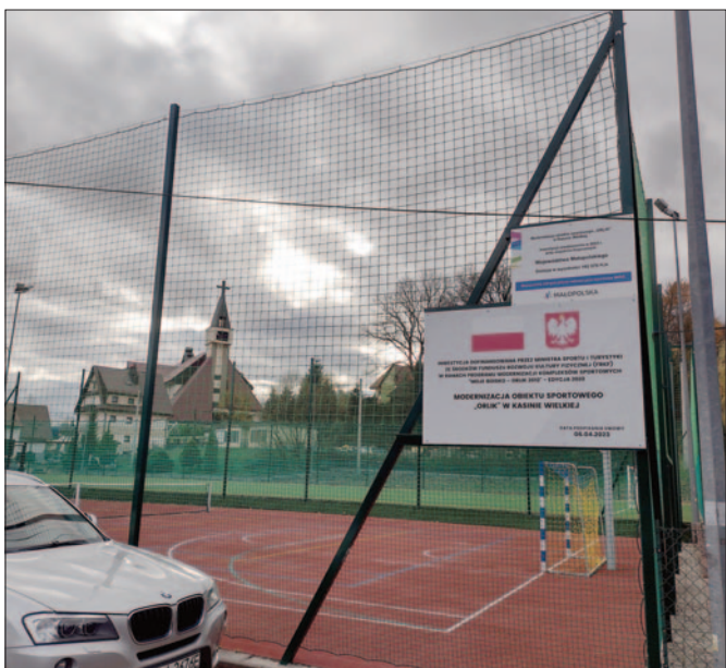
Wyremontowany Orlik w Kasinie Wielkiej
